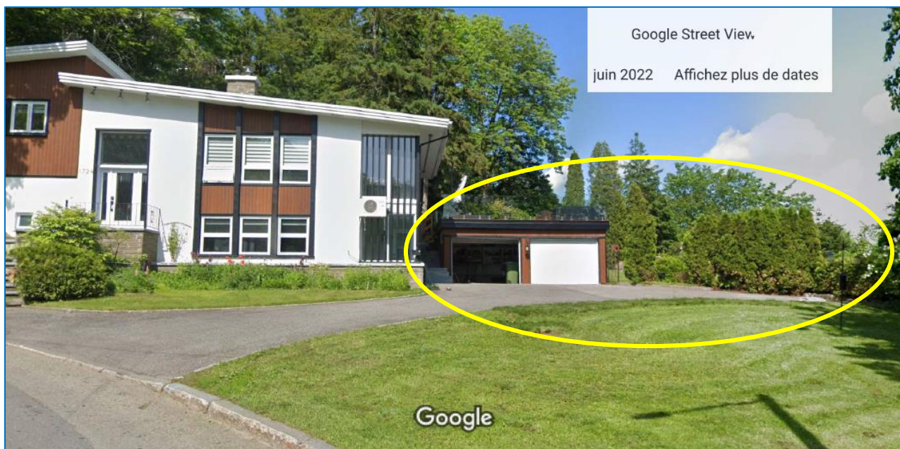
Partie visée par la demande de modification
